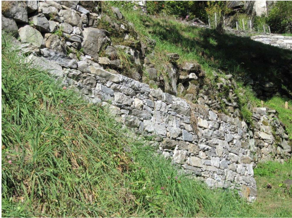
Neue Mauer, Position 5
