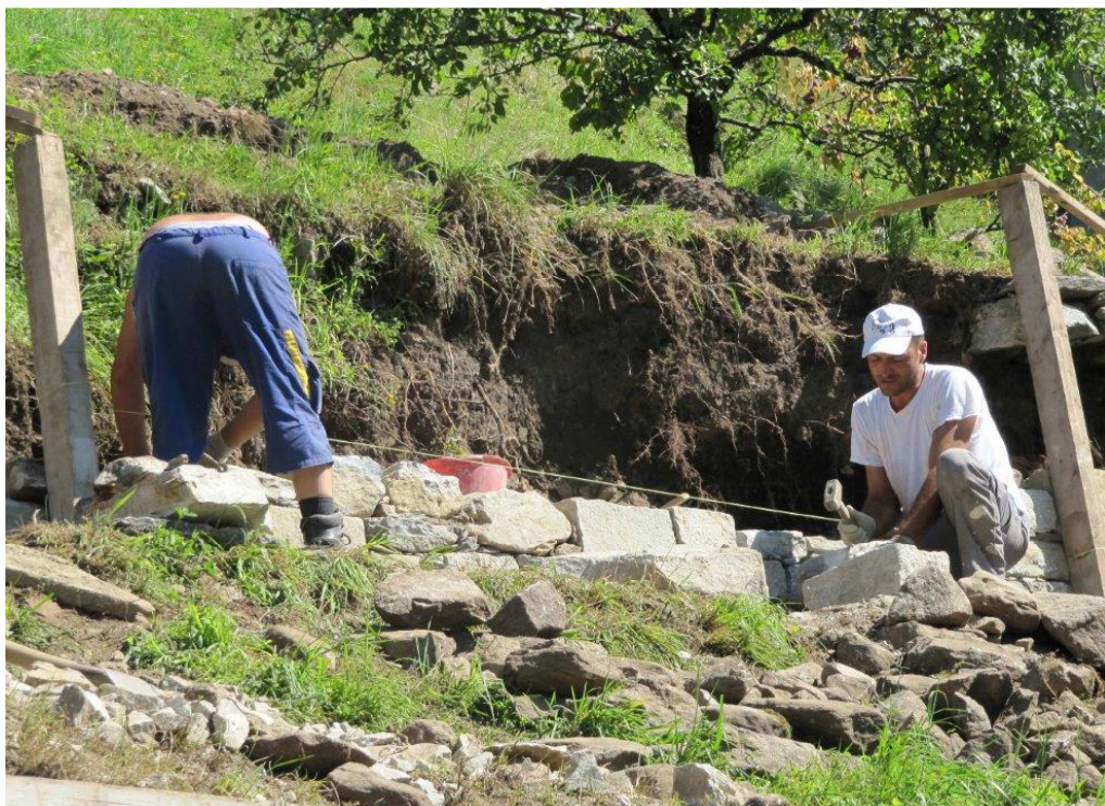
Trockenmauern bauen benötigt Fachkenntnisse und Erfahrung
