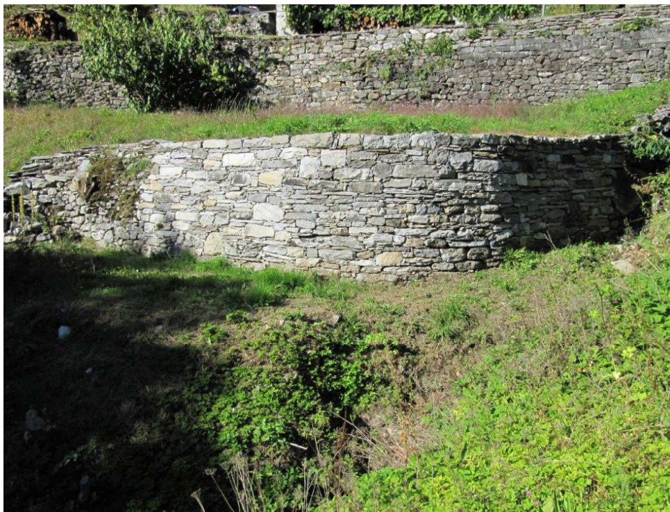
Neue Mauer, Position 3
