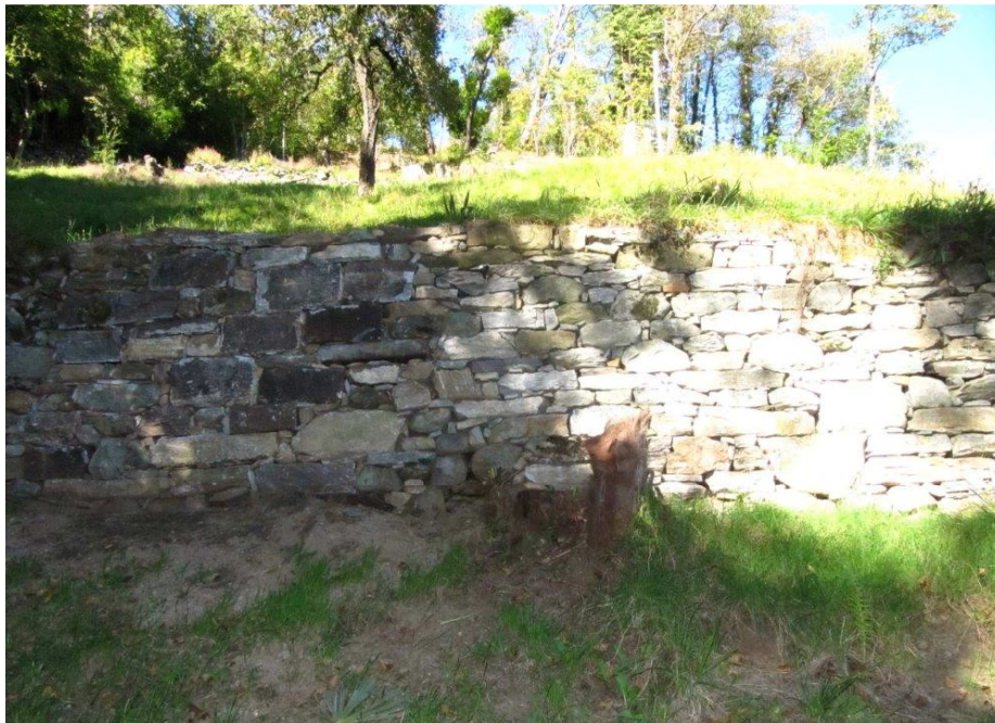
Neue Mauer, Position 7
