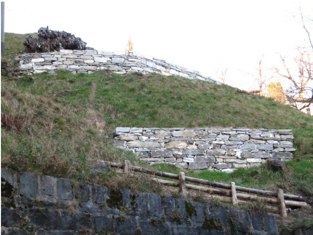
Neue Mauern, Positionen 8 und 6; Schutzverbauung, Position 10
