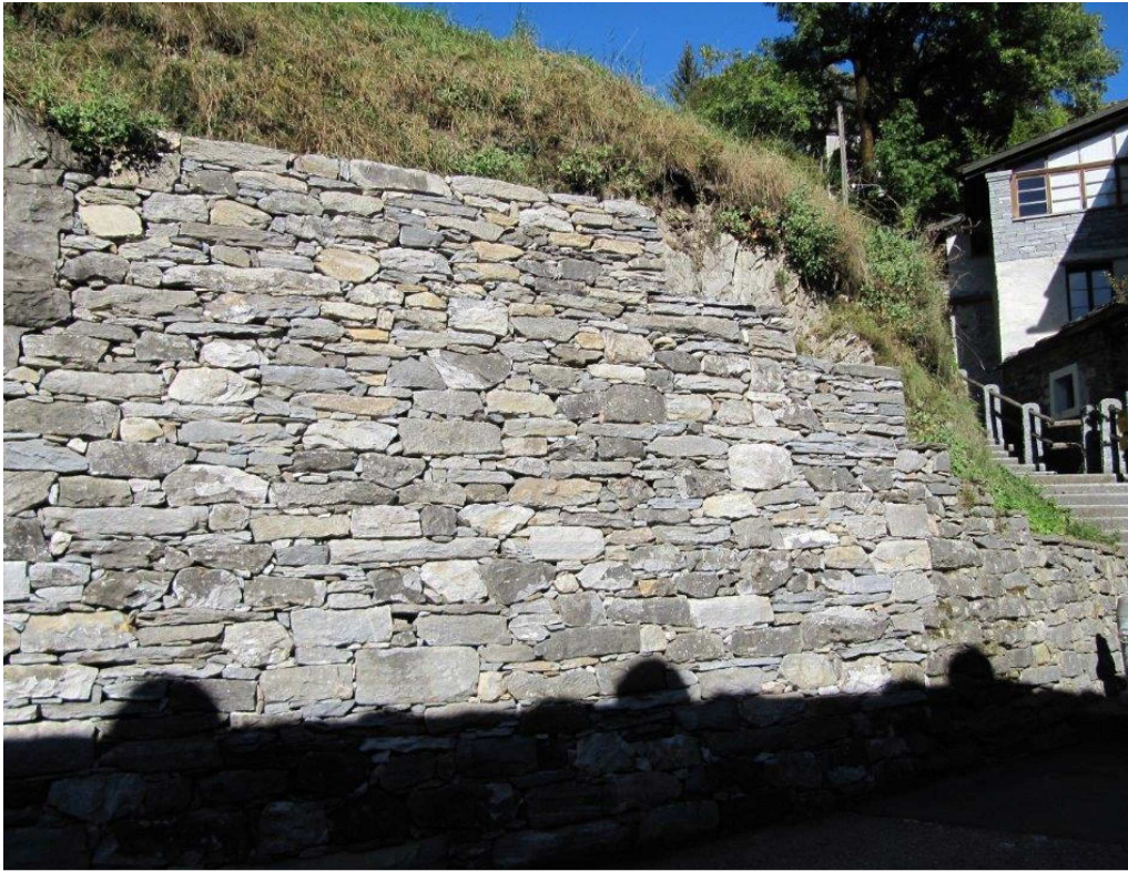
Neue Mauer, Position 9
