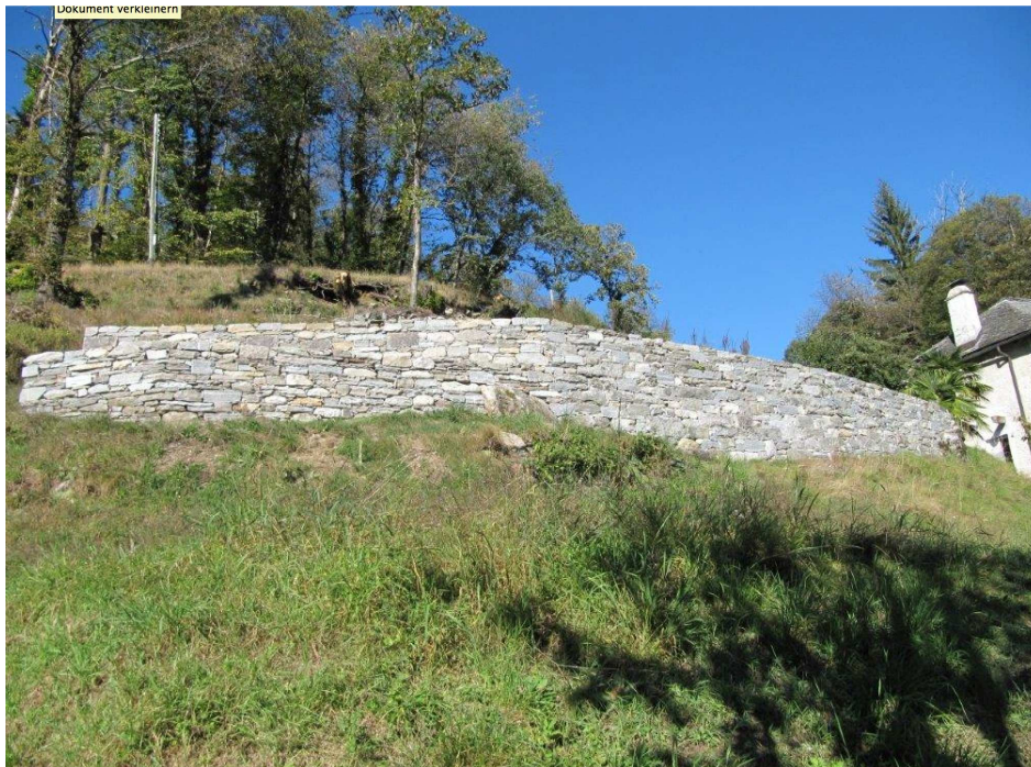
Neue Mauer, Position 1
