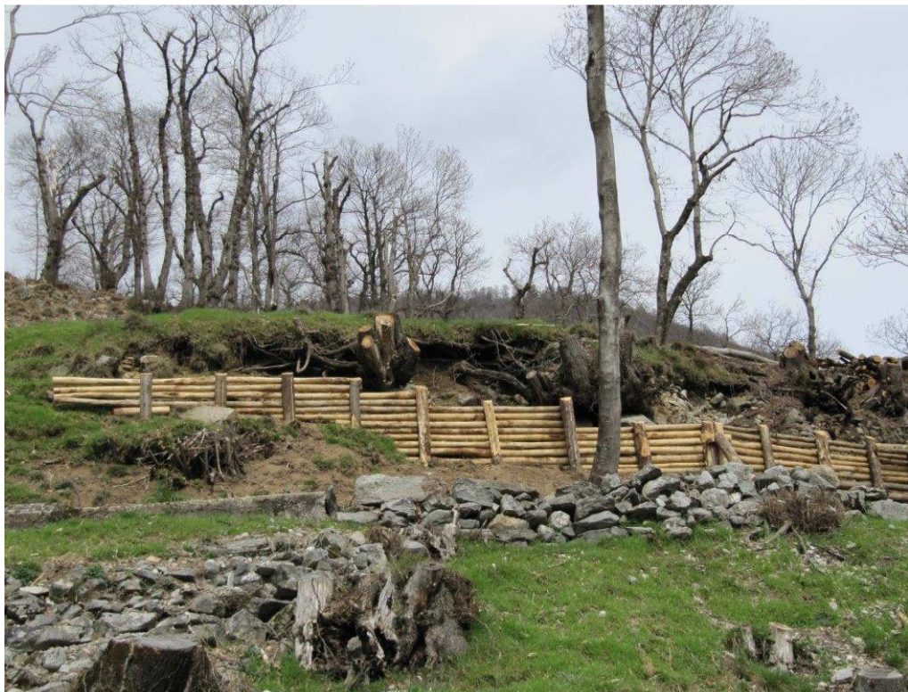
Schutzverbauung, Position E
