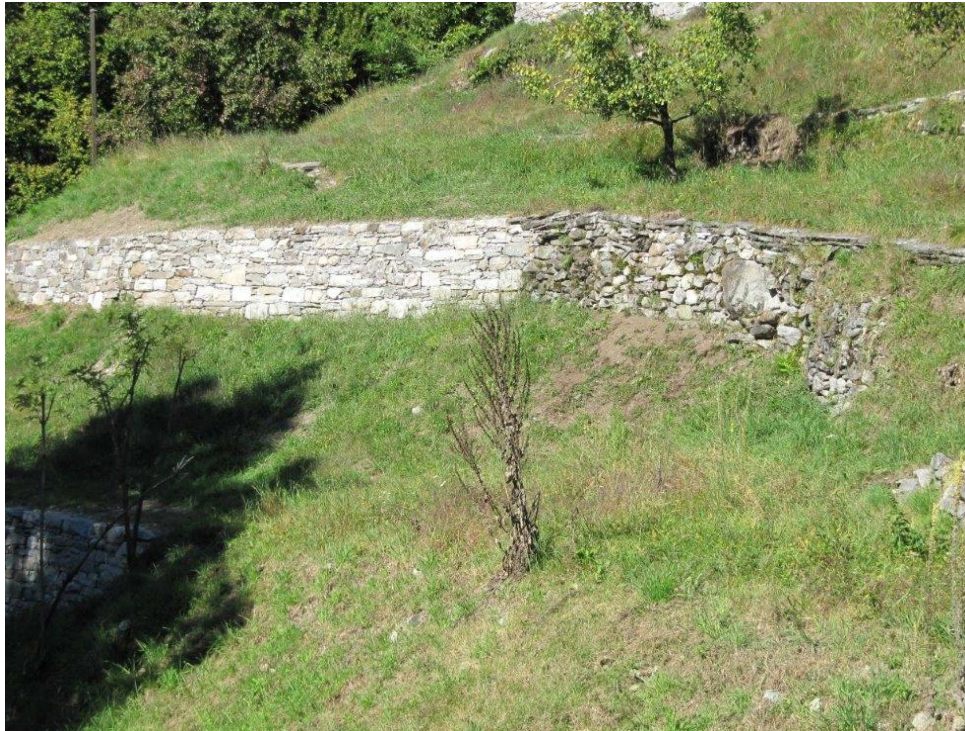
Neue Mauer, Position 2
